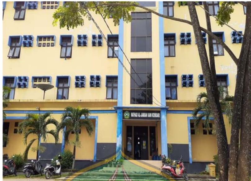
Gambar 1. Gedung Ma'had al-Jami'ah IAIN Kendari
