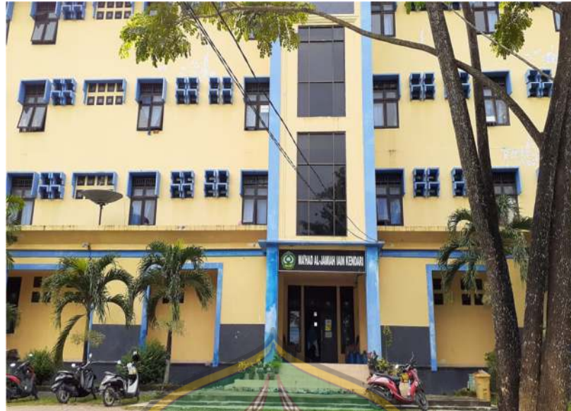
Gambar 1. Gedung Ma'had al-Jami'ah IAIN Kendari
