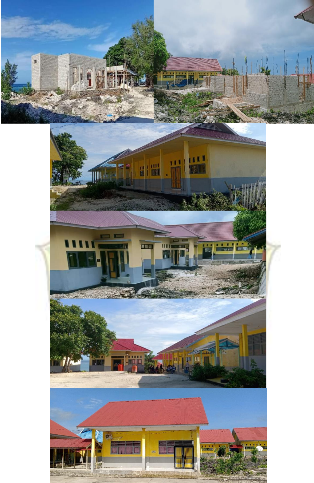
Dokumentasi gedung sekolah sebelum dan setelah pembangunan
