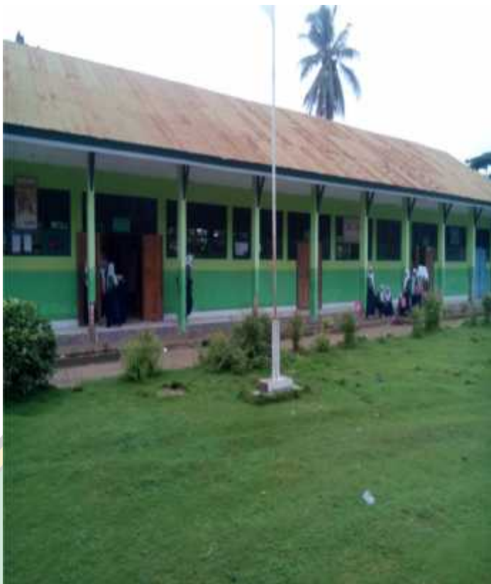
Gedung Kelas VII MTsN 1 Konawe Kepulauan
