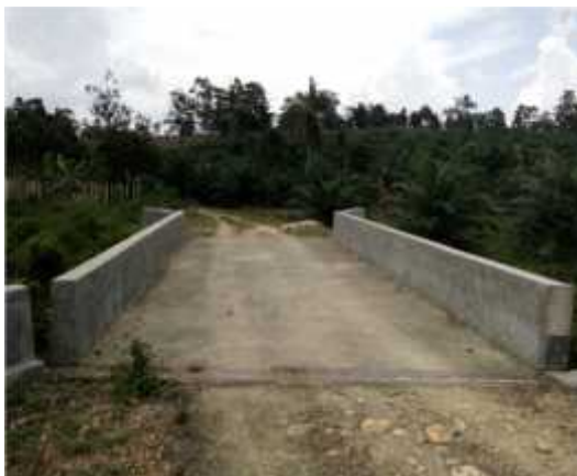
Perbaikan jembatan di desa Lamolori
