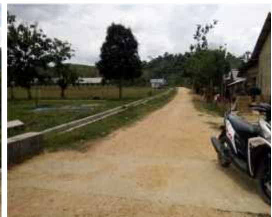
Perbaikan Jalan di Desa Tetesingi
