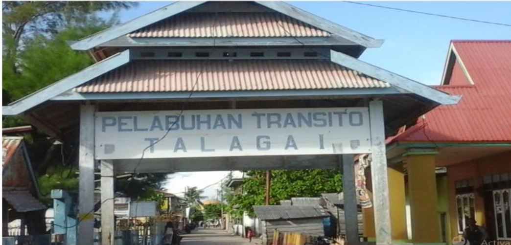
GERBANG DAN NAMA PELABUHAN SEBELUM NYA
